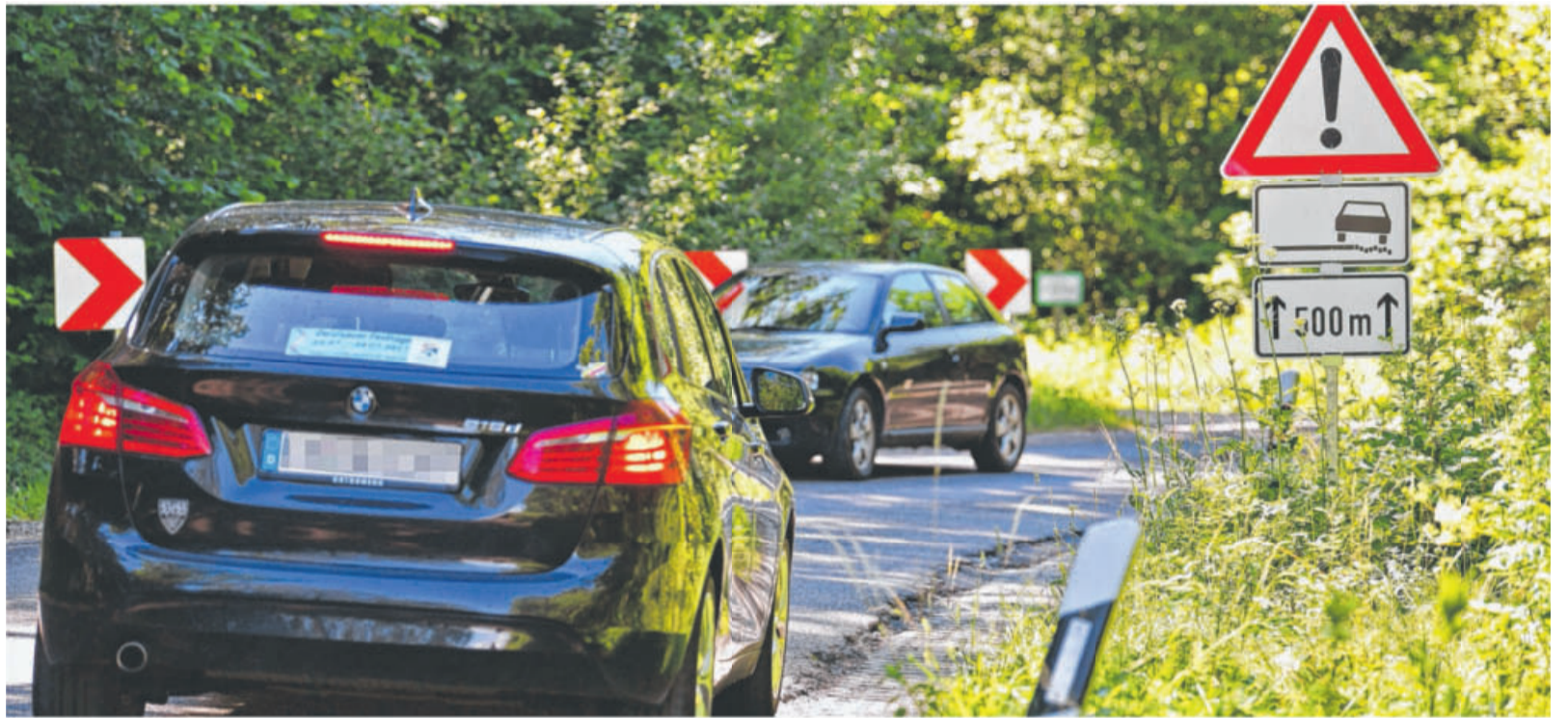
Noch geht es eng zu auf der maroden Kreisstraße zwischen Schlierbach und Ohmden. Das soll sich nächstes Jahr ändern. Die Fahrbahn wird breiter, und es kommt auch der lang ersehnte Radweg. Nun ist aber eine neue Kostenrechnung aufgetaucht. Foto: Markus Brändli
