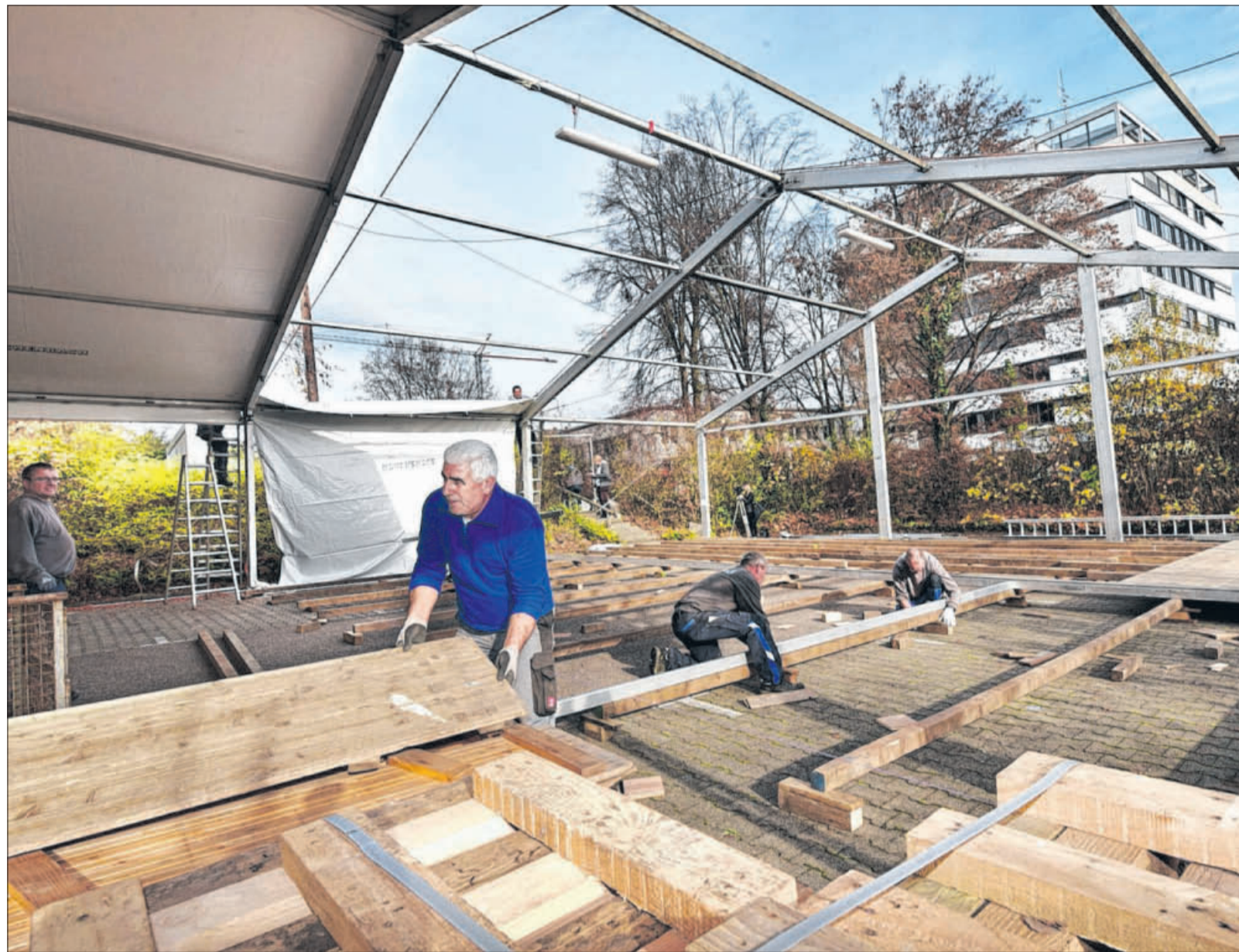
Hinter dem Landratsamt wurde gestern auf dem Mitarbeiterparkplatz ein Zelt als Notunterkunft für 80 Flüchtlinge aufgebaut.
